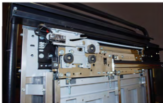
Particolare del meccanismo apertura porta. МЕХАНИЗМ ШАХТНОЙ ДВЕРИ
